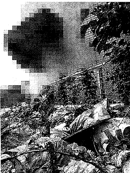
建物の周囲もごみの山(写真はとも一部を加工)
